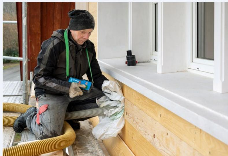
Zellulose wird hinter die Schindelfassade eines denkmalgeschützten Appenzellerhauses geblasen. Die Sanierung wurde durch das Gebäudeprogramm unterstützt.
